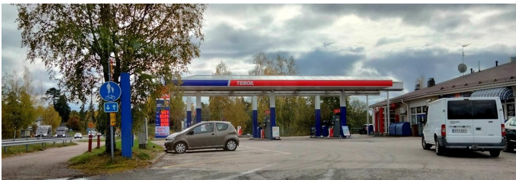
Kuva 23. Nurmin keskustassa, Kaitavedentiellä sijaitsee huoltoasema.
